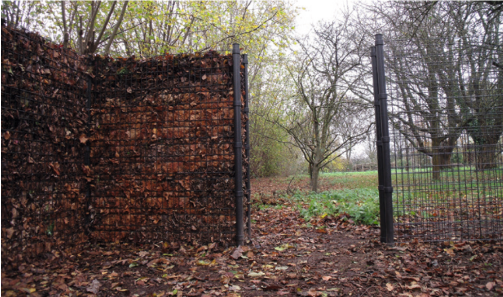
Voor de bouw van deze bladwand werd gekozen voor stevig, decoratief traliewerk gemonteerd tussen metalen palen.
