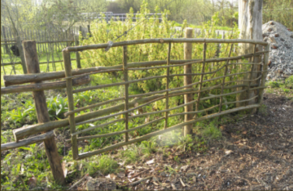
Deze grote poort heeft enkel wat schroeven en hoekijzers gekost. Om te voorkomen dat ze doorbuijt, werd ze met een kabel opgehangen aan de hoge hoekpaal.
