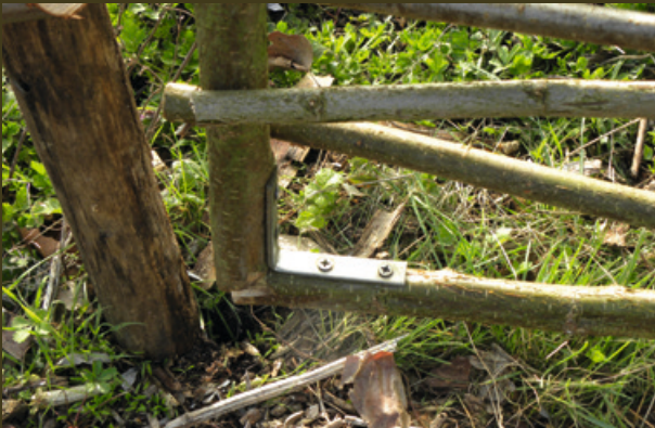
Deze grote poort heeft enkel wat schroeven en hoekijzers gekost. Om te voorkomen dat ze doorbuijt, werd ze met een kabel opgehangen aan de hoge hoekpaal.
