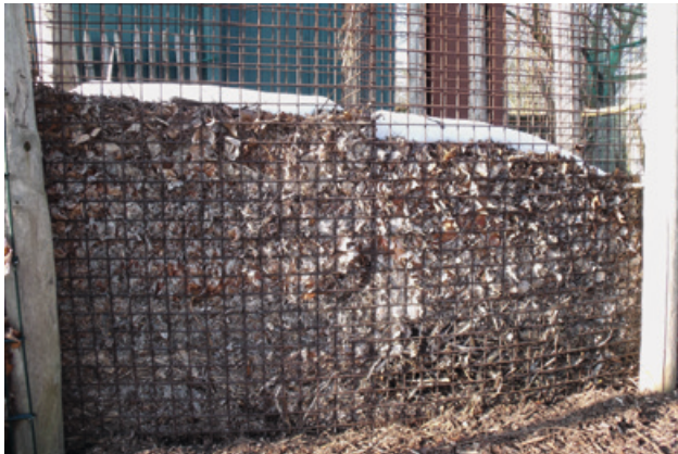
Met enkele dikke houten palen, stevig in de grond verankerd en verbonden met fijnmazige betonroosters, bekomt u een eenvoudige bladwand die vele jaren standhoudt.
